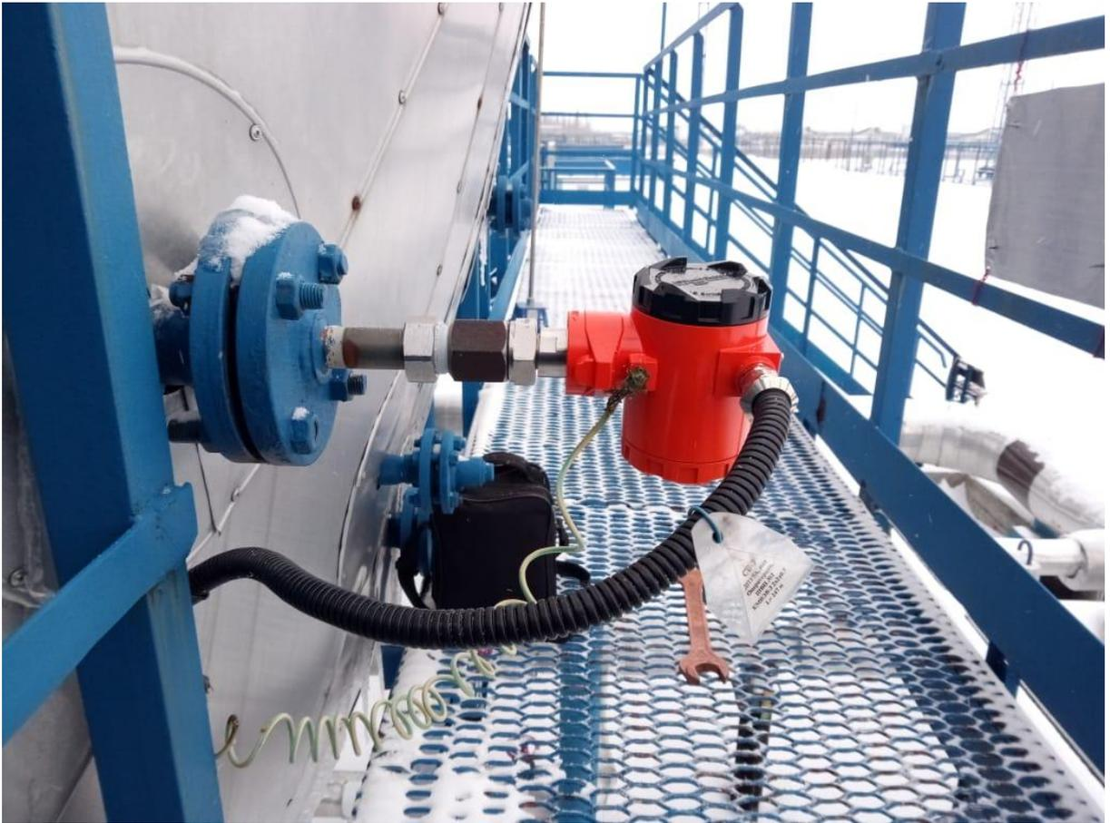
Рисунок 5: Сигнализатор уровня Вибротач на СВ-3
