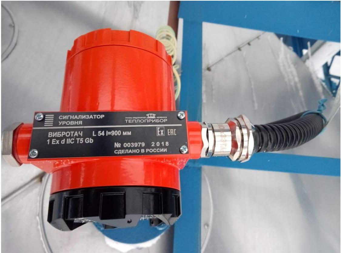
Рисунок 4: Сигнализатор уровня Вибротач Маркировка
